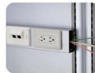
■桌下網路/電源線槽
